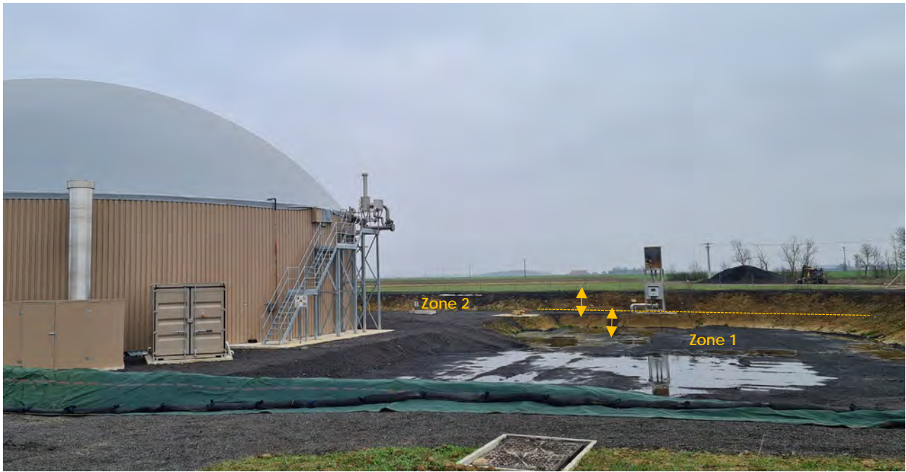
Figure 21. Zone de rétention sur le site principal de la SAS R&D BIO ENERGY
